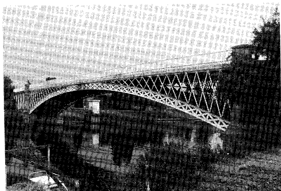
写真 6 イギリスのMythe橋(1836年, スパン170ft (51.8 m))
