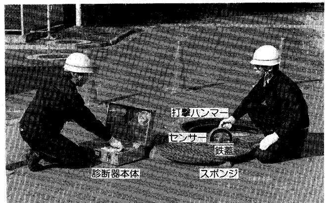
写真1 鉄蓋劣化診断器による測定状況
