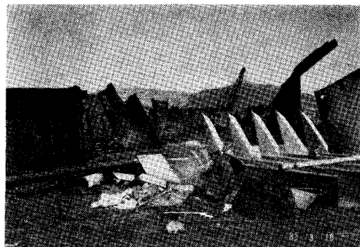
写真 2 解体作業状況
