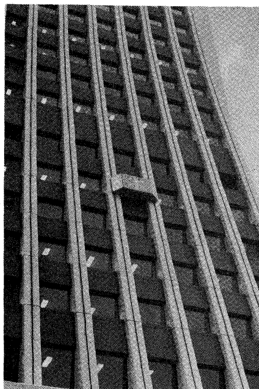
写真6. 壁面を上下するクリーニングユニット
