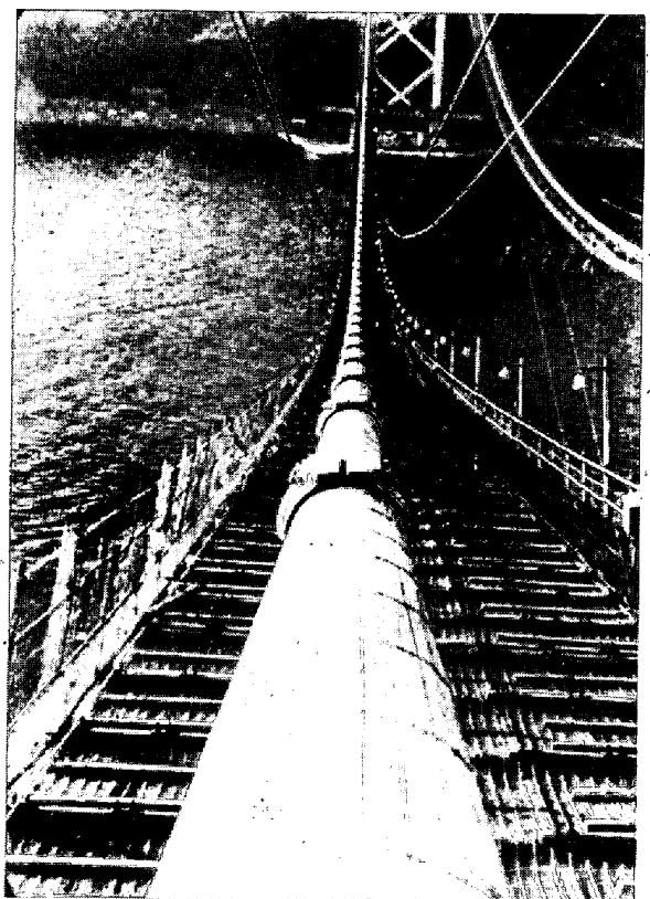
写真22 完成した関門ケーブル
