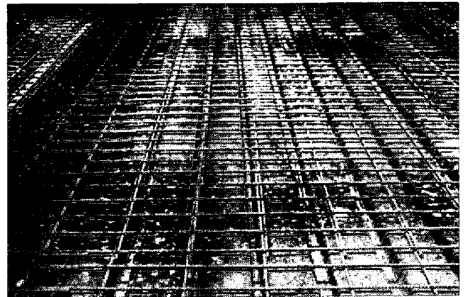
写真14 メッシュ配筋状況
