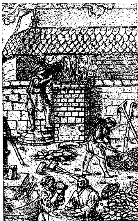
図2 シュティック炉 (Stückofen) 9) (Agricola : De re metallica, 1556 より)
