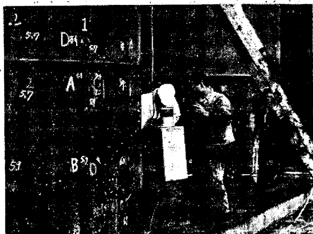
第 24 図 超音波厚み計による薬品タンクの腐蝕度測定状況
