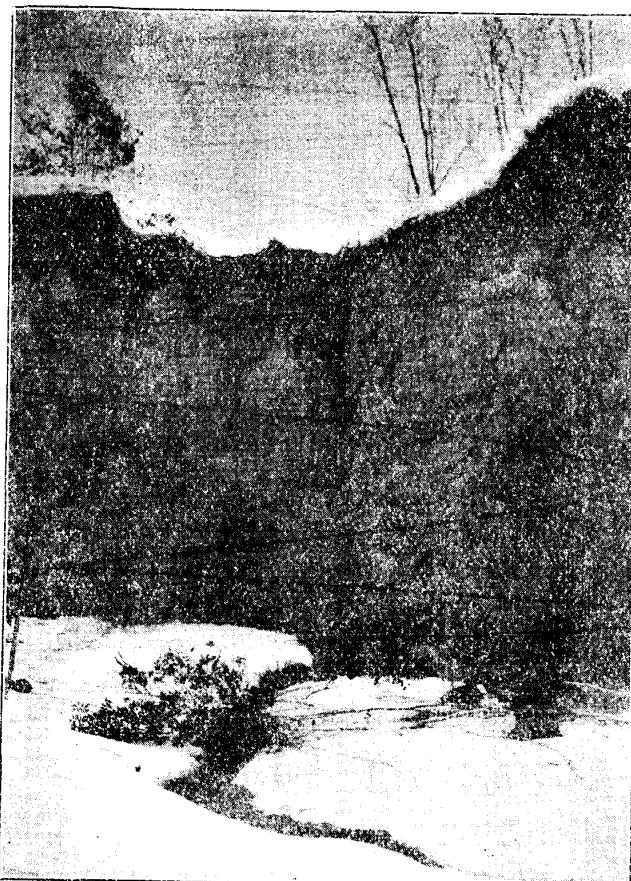
第二圖　鳥取縣日野郡印賀村近藤喜兵衛氏所有砂鐵採取場に於て高さ約五六十尺の土砂將に崩壊せんとする狀態を撮影せるものなり（大正七年一月十三日午前十一時）
