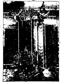
第 19 圖 爐用變壓器(リアクトル及びタップ切換器内蔵)
