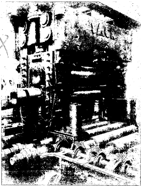
第 11 圖 Marrel の壓延機用スタンデル・ローラの駆動装置
