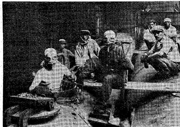
し完全に瓦斯を排除し作業に就くも、多量の灰堆積し居れば、其の灰の中に殘留する瓦斯の爲に中毒を起す。本作業時の瓦斯管は直徑 2 m、灰約 20 脇を排出す。(昭和 4 年 6 月 3 日寫)
